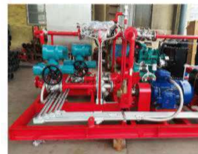
平衡式比例混合装置（一电一柴）
