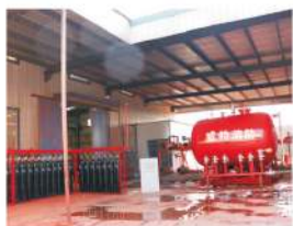
PWZ系列泡沫喷雾灭火装置
