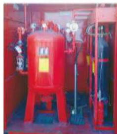
单储罐干粉灭火装置
