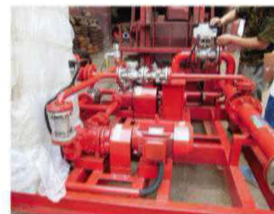
平衡式比例混合装置（一电一水）
